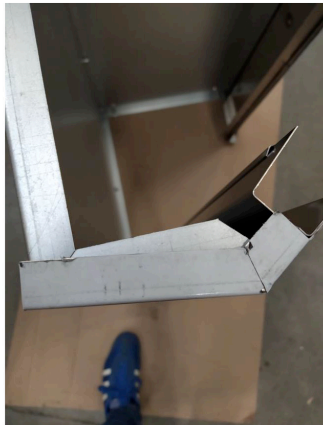
Placer la plaque 1a par-dessus le retour à 90° de la tôle 1b
